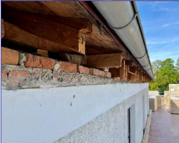
Das Dachgesims ist zurückgebaut, die Verkleidung - bestehend aus alten Schilfmatten - ist entfernt.
