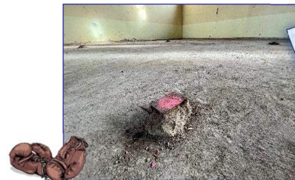
Im Boden sieht man alte Bodenstützen für einen Boxring.
