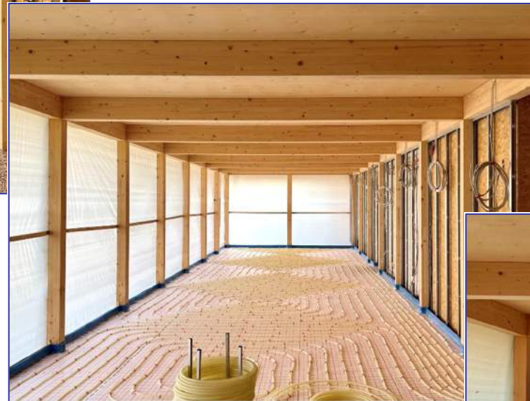
Schneckenförmig gelegte Polyethylen-Heizrohre
