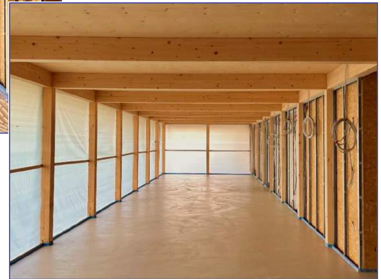
Schwimmender Fließestrich umschließt die Fußbodenheizung
