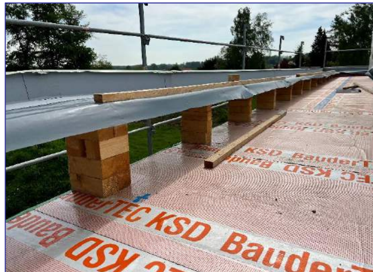
Auf dem neuen Flachdach erkennt schon man das spätere Gefälle.
