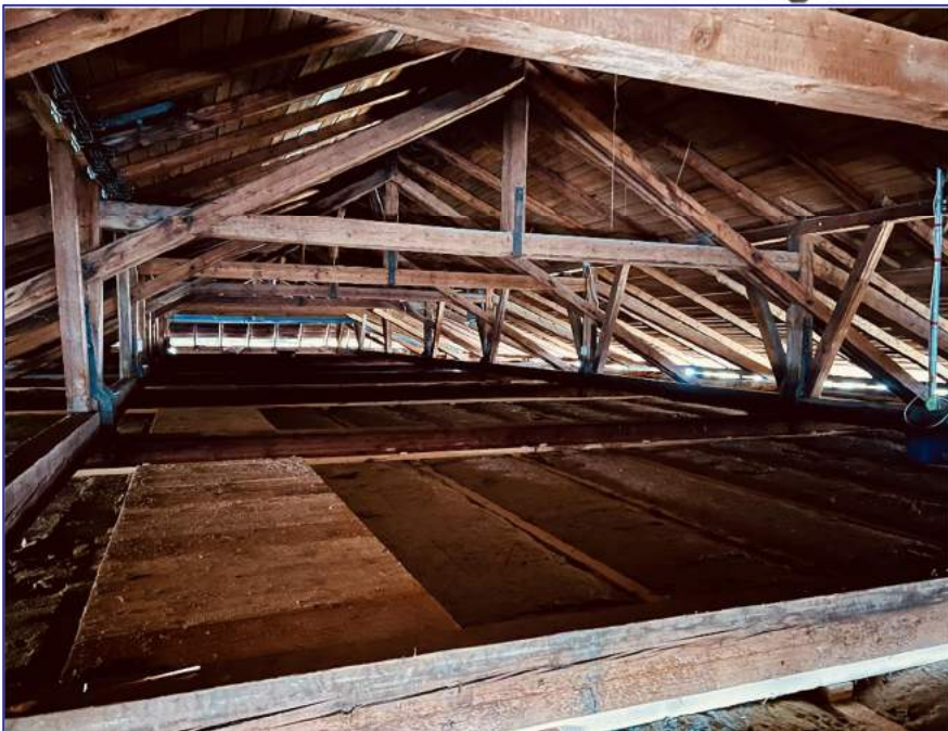
Ein Blick vom Dachstuhl auf die isolierte neue Holzdecke.
