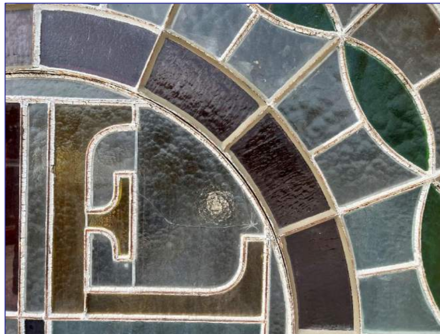
Die ausgetauschten Fensterscheiben sind am noch frischen Fensterkitt zu erkennen.
