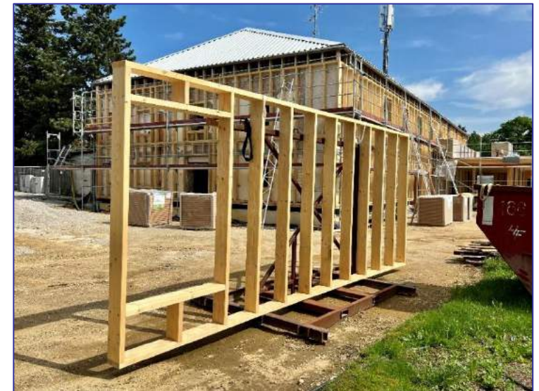
Das letzte Dämm-Holzrahmenelement wartet auf den Einbau.
