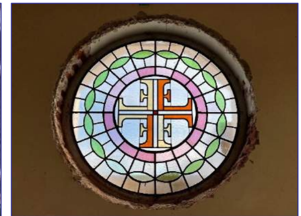
Die neu eingesetzten Fensterscheiben sind etwas heller.
