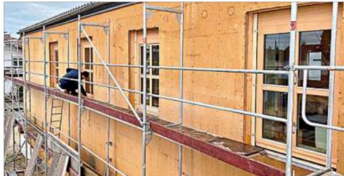
Architekt Michael Kremsreiter begutachtet den Einbau vor Ort. Die historische Jahnturnhalle bekam passende Lärchenfenster.
