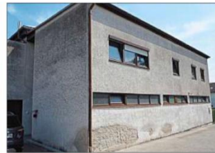
Der Anbau mit Duschen, Umkleiden und Toiletten sowie Hausmeisterwohnung entstand in den 70er Jahren. Er wird abgerissen.
