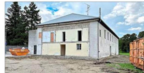
So sieht das Grundstück im Moment aus. Den alten Eingang der Jahnturnhalle, wie er vor den 70er Jahren aussah, kann man sich jetzt gut vorstellen. Jetzt geht es innen mit der Sanierung weiter.
