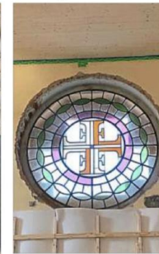
Das historische Rundfenster ist bis auf die vier F's bereits fertig restauriert. Es konnte im Zuge der Sanierung wieder in der Halle freigelegt werden.
