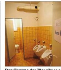
Den Charme der 70er gibt es auf den Toiletten zu sehen.
