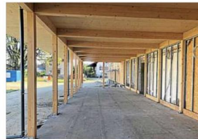
Der neue Eingangsbereich wartet derzeit nur noch auf die bodentiefen Fenster (links). Wegen Problemen mit dem Fensterbauer verzögert sich die Baustelle.
