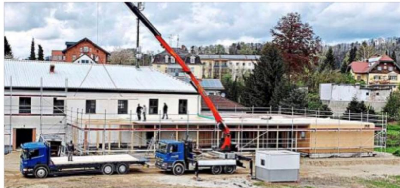
Innerhalb von nur wenigen Tagen wuchs der Anbau an die Jahnturnhalle in die Höhe. – Fotos: TSV
