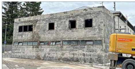
Entkernt bis auf den nackten Beton: Wie ein Bau-Gerippe aus längst vergangener Zeit sah der Anbau kurz vorm Abriss aus. Der TSV war hier mit viel Eigenleistung gut vorangekommen.
