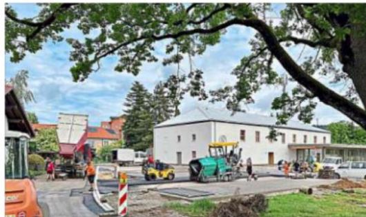
Die Einfahrten zum Parkplatz werden asphaltiert, nachdem die Stellplätze und der Zugang zur Halle fast fertig gepflastert sind. Vor und neben der Luitpold-Eiche wird eine Blumenwiese mit Obstbäumen angelegt.
