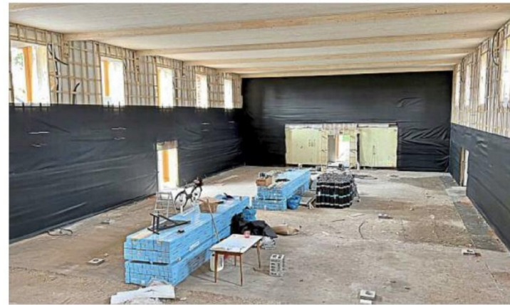
Die neue Decke in der Jahnturnhalle ist bereits fertig. Die Wände wurden vorbereitet für den Einbau der Prallwände. Was jetzt noch fehlt, sind die Fenster.
