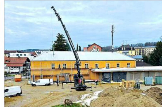
Nachdem das Wetter dem Einbau einen Strich durch die Rechnung gemacht hatte, wurden die Fenster vergangene Woche eingebaut.
