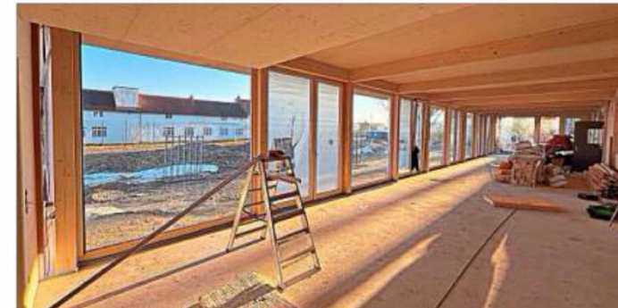
Hell und einladend wirkt das Begegnungszentrum mit den neuen Fenstern.
